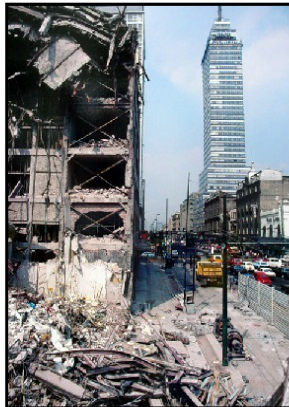
(a) Edificios de la ciudad de México con características en común derrumbados en el sismo del 25 de Abril 1989
