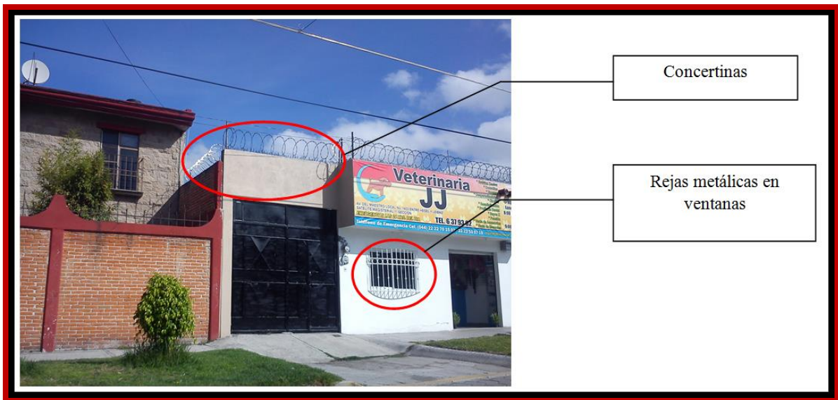
Fotografía 22. Aquí se observan dos medidas de seguridad para proteger tanto la vivienda como el local.
