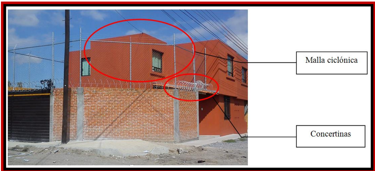
Fotografía 21. Aquí podemos observar dos medidas de protección, concertinas y malla ciclónica.
