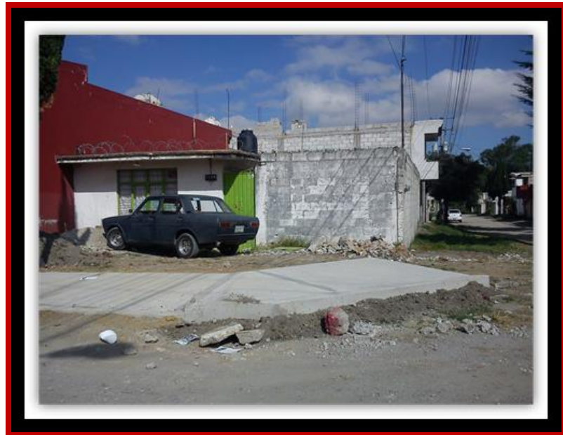
Fotografía 3. Casa ubicada en la calle Demócrito, aquí se observa que el material empleado es block.
