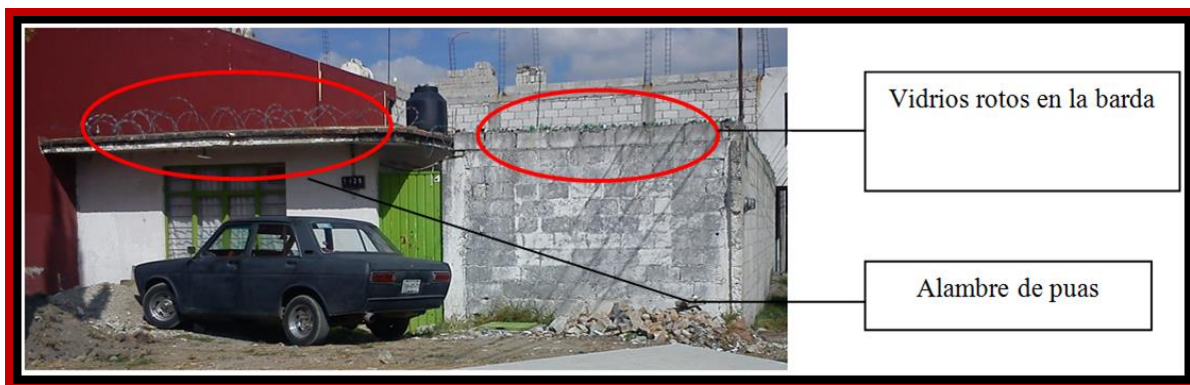
Fotografía 9. En esta vivienda encontramos alambre de puas y vidrios rotos como protección.
