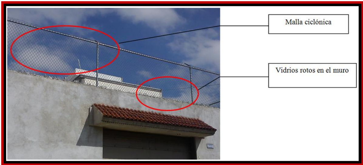
Fotografía 16. En esta vivineda se emplearon dos medidas de seguridad, malla ciclónica y vidrios rotos en el muro.
