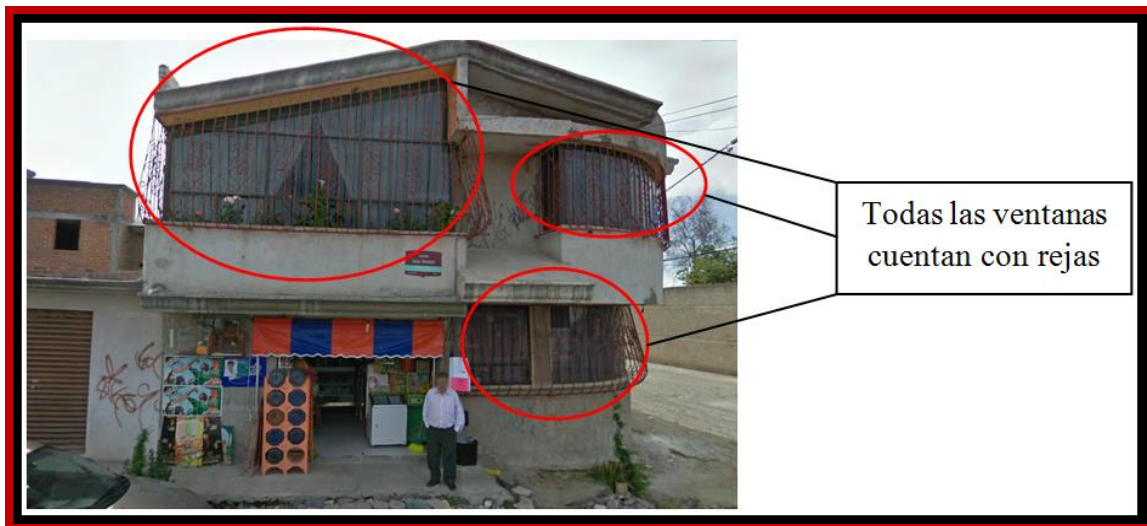
Fotografía 4. En esta fotografía podemos observar que la medida que utilizan para mitigar el delito es el empleo de rejas metálicas de barrotes tipo pecho de paloma torsionados.
