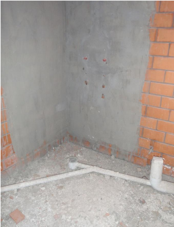
VISTA AREA REGADERA BAÑO PLANTA ALTA
