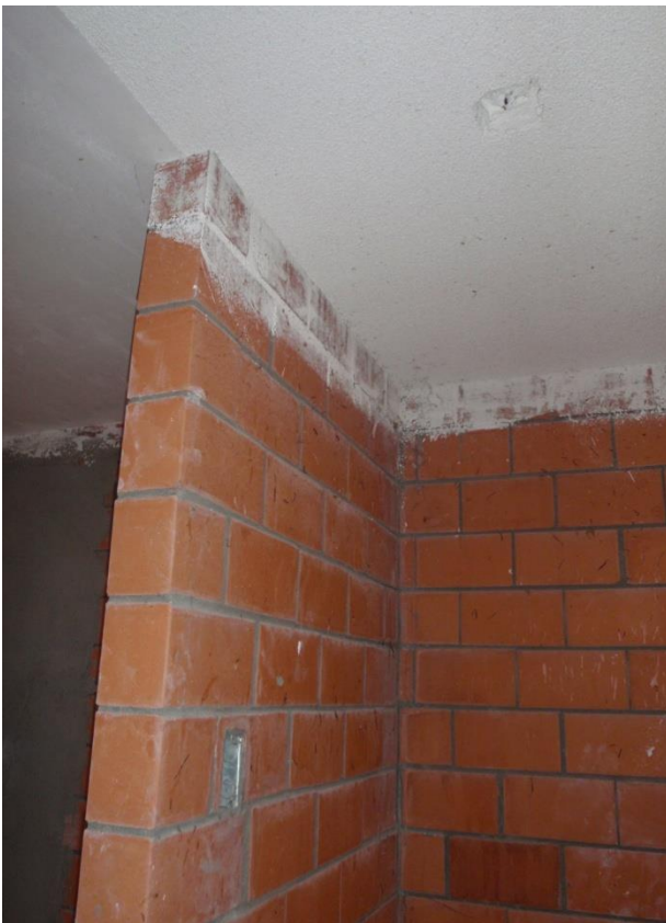
VISTA PLAFON PLANTA ALTA
