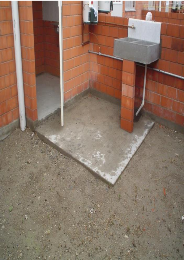
PATIO DE SERVICIO
