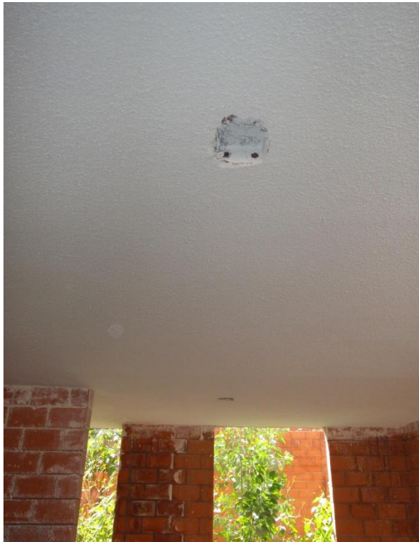
VISTA PLAFON PLANTA BAJA
