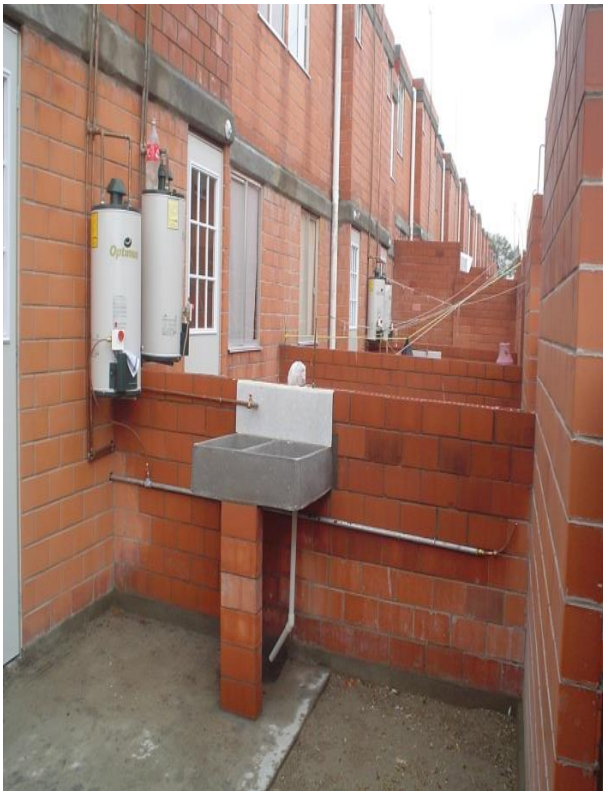
PATIO DE SERVICIO
