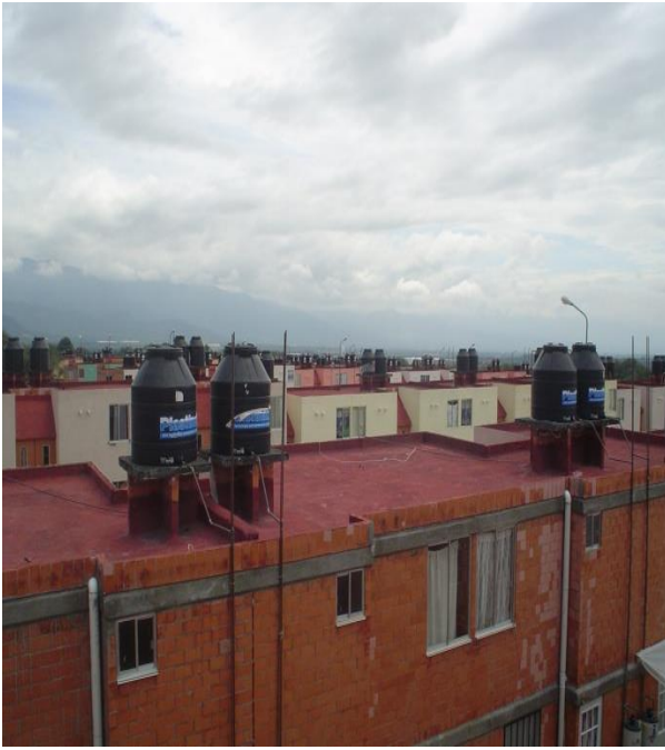
AZOTEAS VIVIENDAS TERMINADAS
