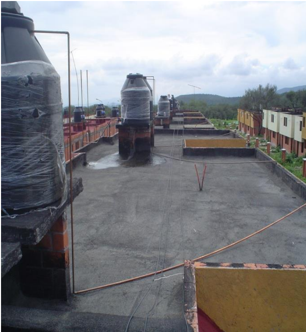
VISTA AZOTEA TERMINADA
