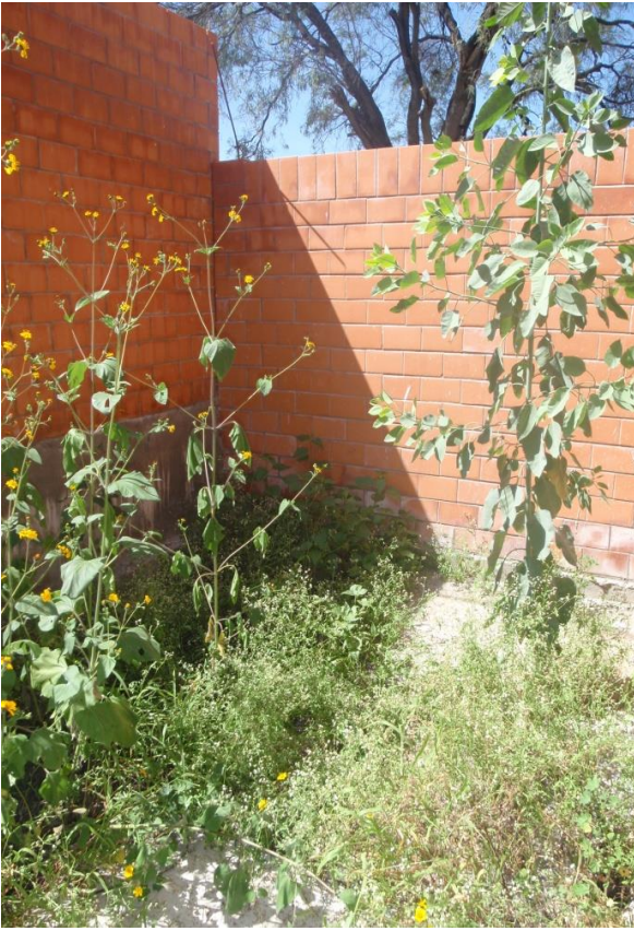
PATIO DE SERVICIO
