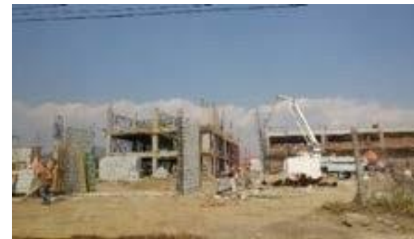
Imagen 13. Construcción de plantel educativo, febrero 2017, colonia La Purísima
