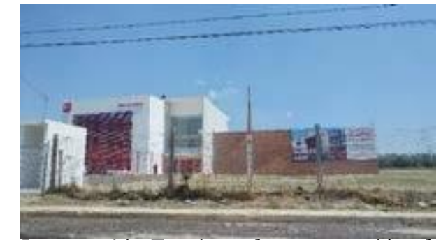
Imagen 14. Termino de construcción de plantel educativo, abril de 2017, colonia La Purísima
