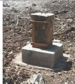
Fotografía 8.- Cimbrado y colado de dado y colocación de birlos para acompamiento de columna de perfil de acero IPR.
