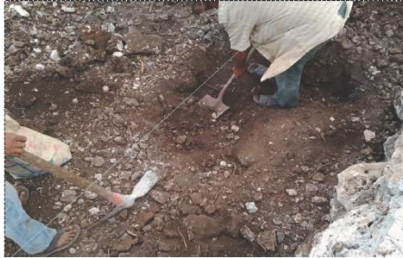
Fotografía 1.- Excavación de cepas por medios manuales.
