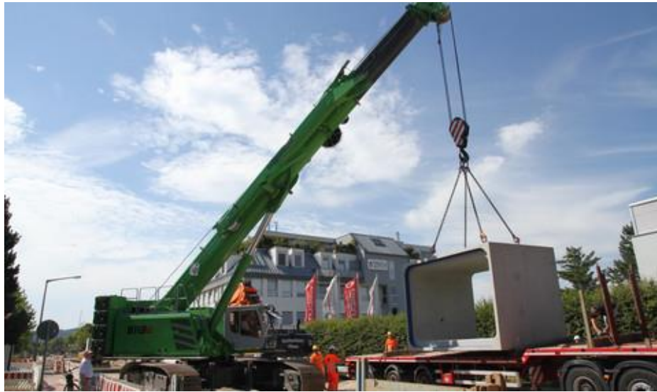
Figura 15. Grúa telescópica para montaje de elementos prefabricados.
