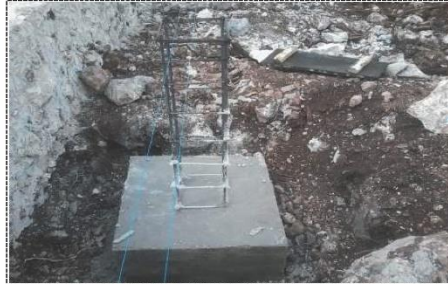
Fotografía 7.- Zapata colada; trazo y alineación previo a colado de dado (para colocación de birlos de anclaje).
