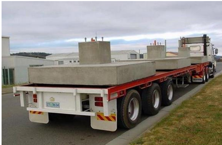
Figura 10. Transporte de zapata prefabricada con tractocamión.
