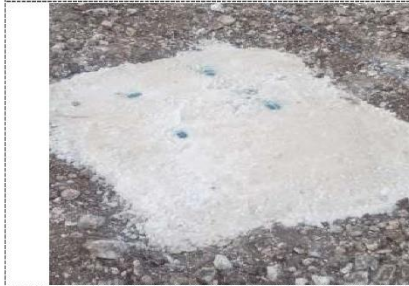
Fotografía 3.- Barrenaciones para anclaje en roca sana.
