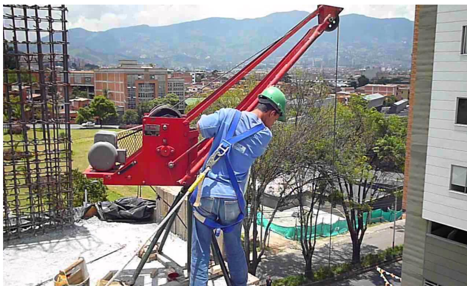
Figura 13. Malacate para maniobras de construcción.
