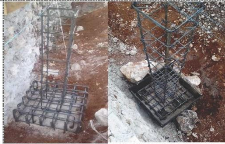
Fotografía 4.- Colocación de armado de acero y anclaje a roca firme, a través de barrenaciones.
