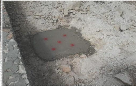
Fotografía 2.- Colado de plantilla y trazo para barrenaciones para anclaje en roca sana.
