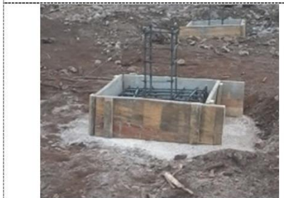
Fotografía 5.- Cimbrado con madera de pino de segunda para colado de zapata.
