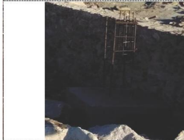
Fotografía 10.- Colocación de birlos de acero, previo a colado de dado nivelador.
