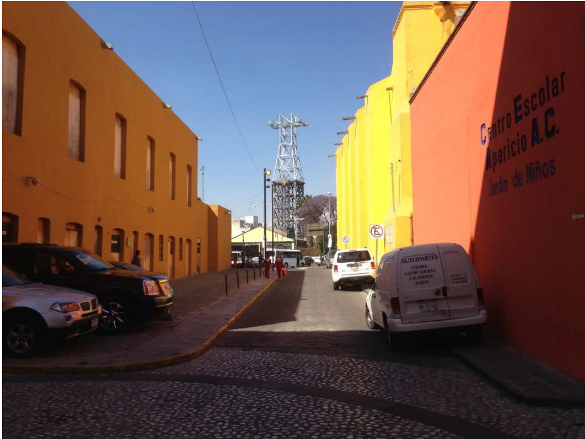
Ilus. 78 – Torre de la primera estación del proyecto teleférico, ubicada en la avenida 14 oriente y calle 6 norte, enfrente del Antiguo Paseo San Francisco y Centro de Convenciones. Predio donde actualmente se encuentra el taller mecánico “servicio Valdés”. Fotografía propia, 2013.
