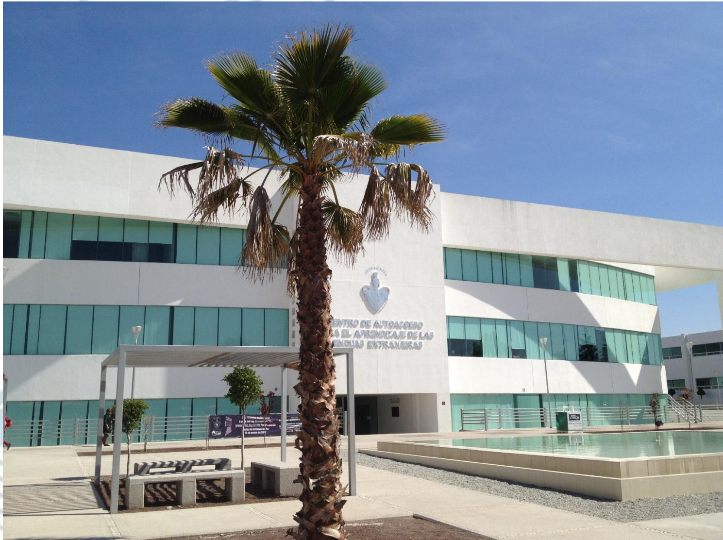
Anexo 8. Fachada posterior Edificio de Autoacceso de Lenguas, C.U. Fuente: Archivo personal.
