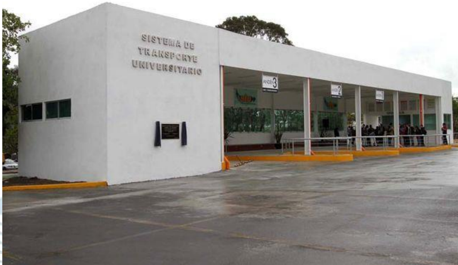
Anexo 21. Terminal STU, Ciudad Universitaria. Fuente: Banco de datos DGO.
